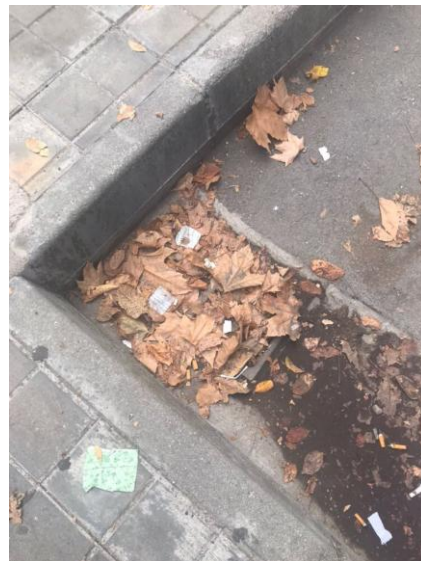
Estado de las alcantarillas
